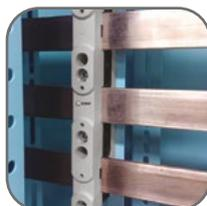
Возможность создания шинных систем без сверления и пробивания шин
