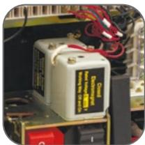
Катушки включения/отключения в базовой комплектации
